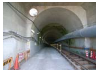
▲第3期工事、540mまで掘削が進む。最終的には1200mまで掘削は行われ、そこから先進導坑が掘られる。
