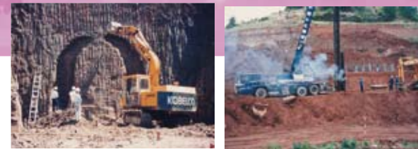
▲重機が導入され基礎杭が打設される (1986年)
