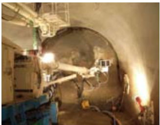
▲第3期工事、540mまで掘削が進む。最終的には1200mまで掘削は行われ、そこから先進導坑が掘られる。
