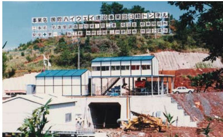
▲日本側始点となる日韓トンネルの調査斜坑現場 (佐賀県唐津市鎮西)
