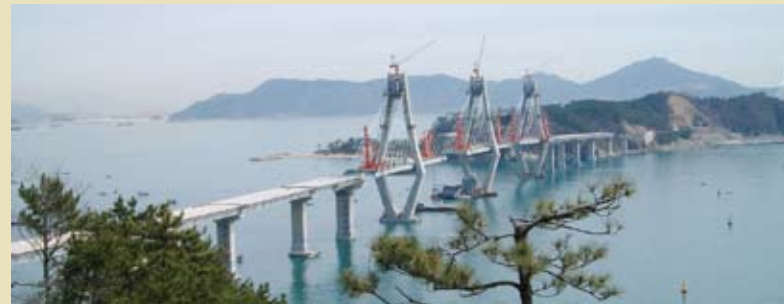
▲韓国・巨済島（建設中の釜山と巨済島を結ぶ橋）
