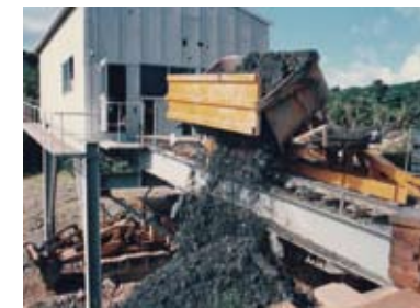
▲掘削された土砂はズリ出し桟橋へ運ばれる
