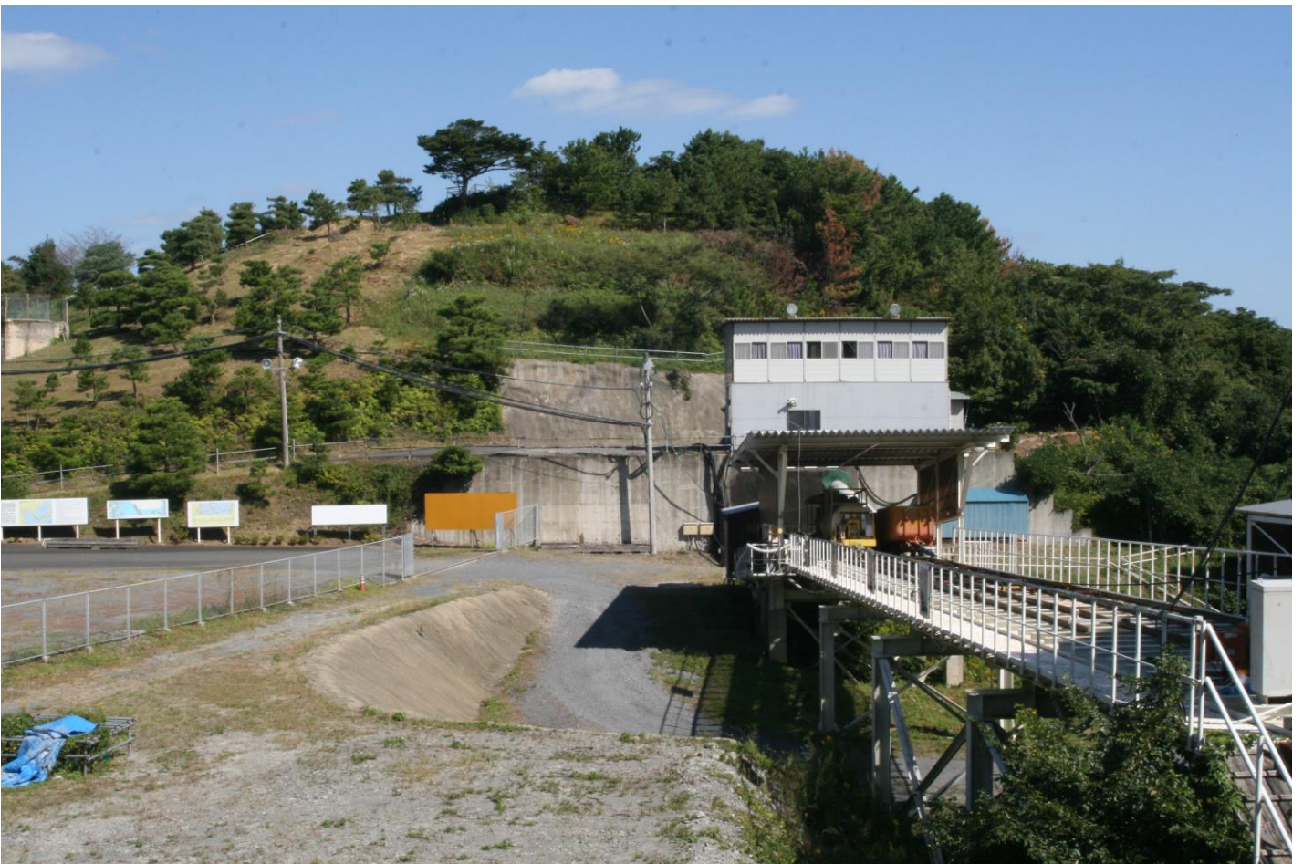
【写真】唐津・名護屋斜坑 坑口周辺
