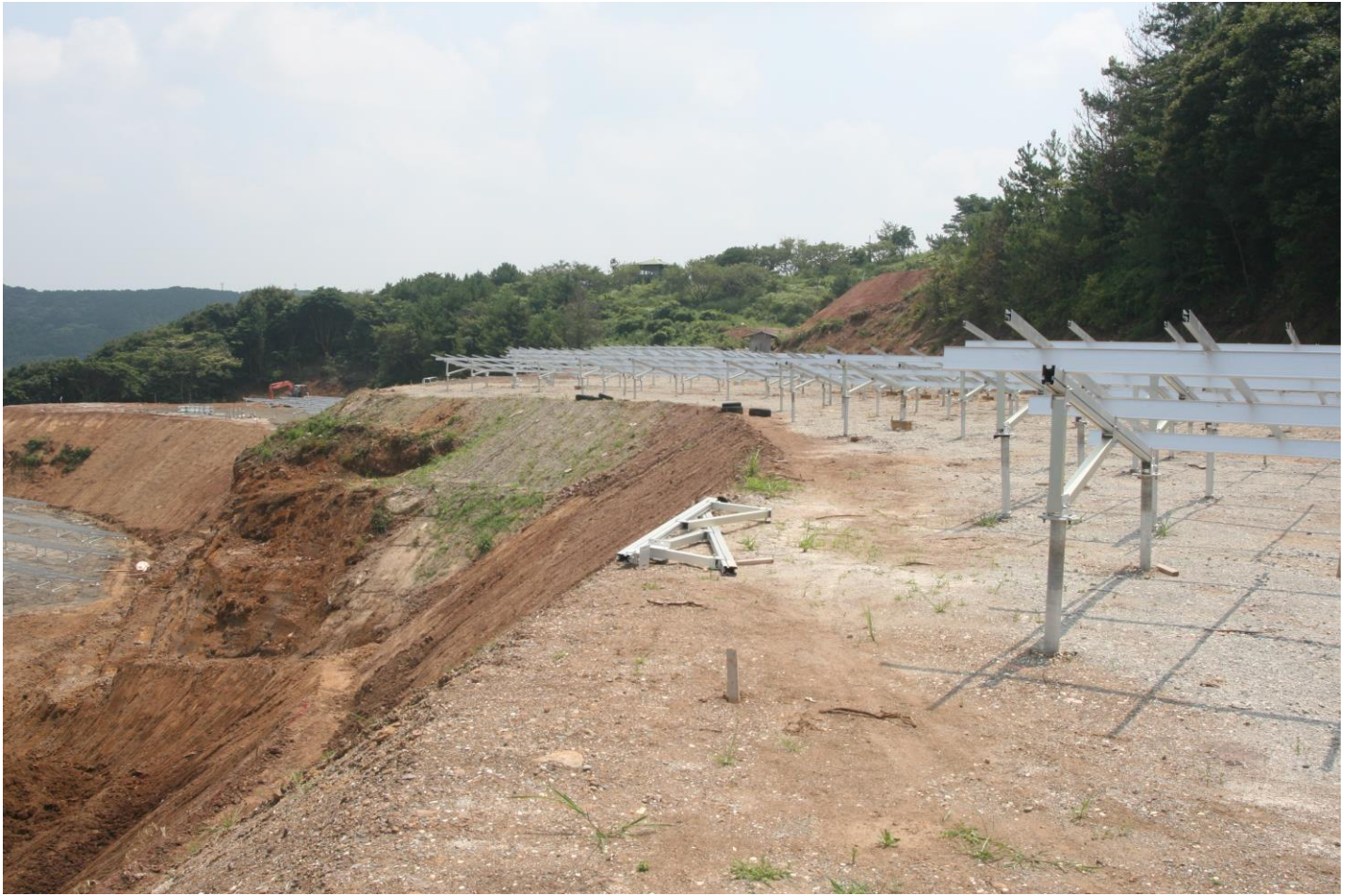
【写真】敷地の中腹部分からパネル土台が据え付けられた 8月5日
