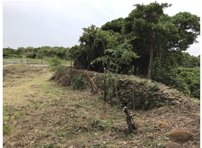
伐採した工事予定地
