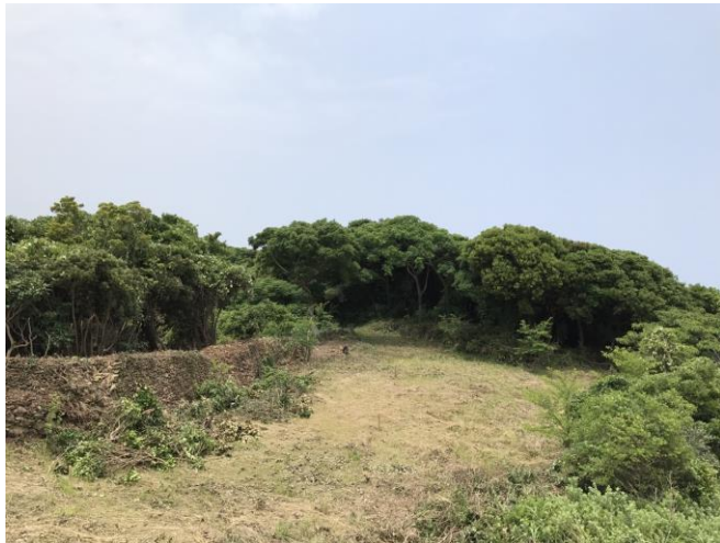
伐採した工事予定地
