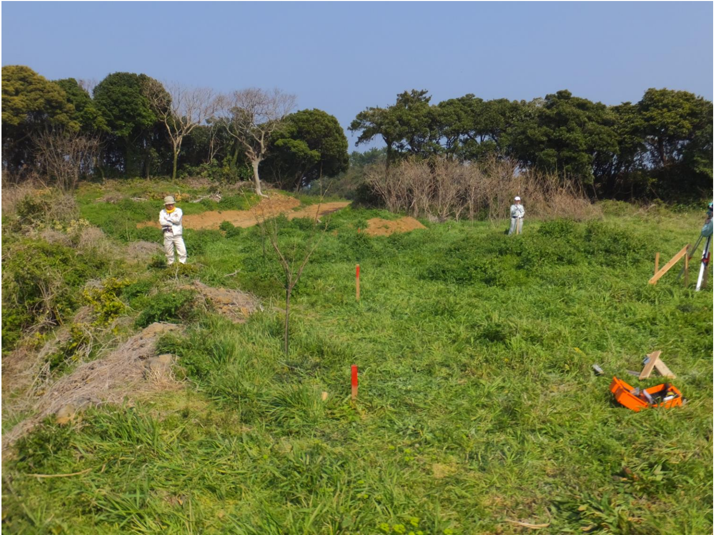
【写真】 坑口予定地 左の人物が直径6mトンネル中央、赤い杭が右側端の線に当り、正面奥の海に向かうこの二段目がトンネルの上面、写真左にある6m下の三段目がトンネルの底となる
