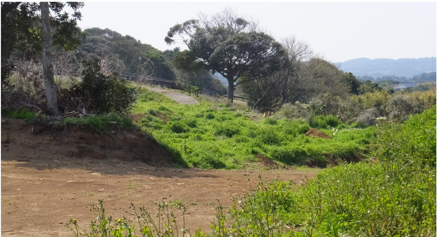
【写真】 写真中央部が斜坑口となる。上に路線バスが通る市道がありウインチはその近くに設置予定 手前の地面は、昨年秋に造成した工事車両が通る進入路 来月4月下旬に工事を行なう予定
