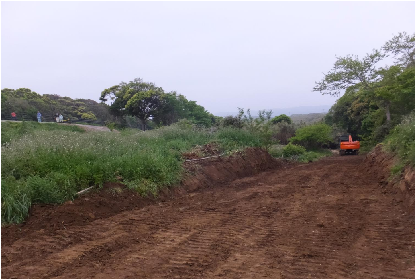
【写真】一日目 左上の市道から坑口の段までの100mの車両進入路ができた
