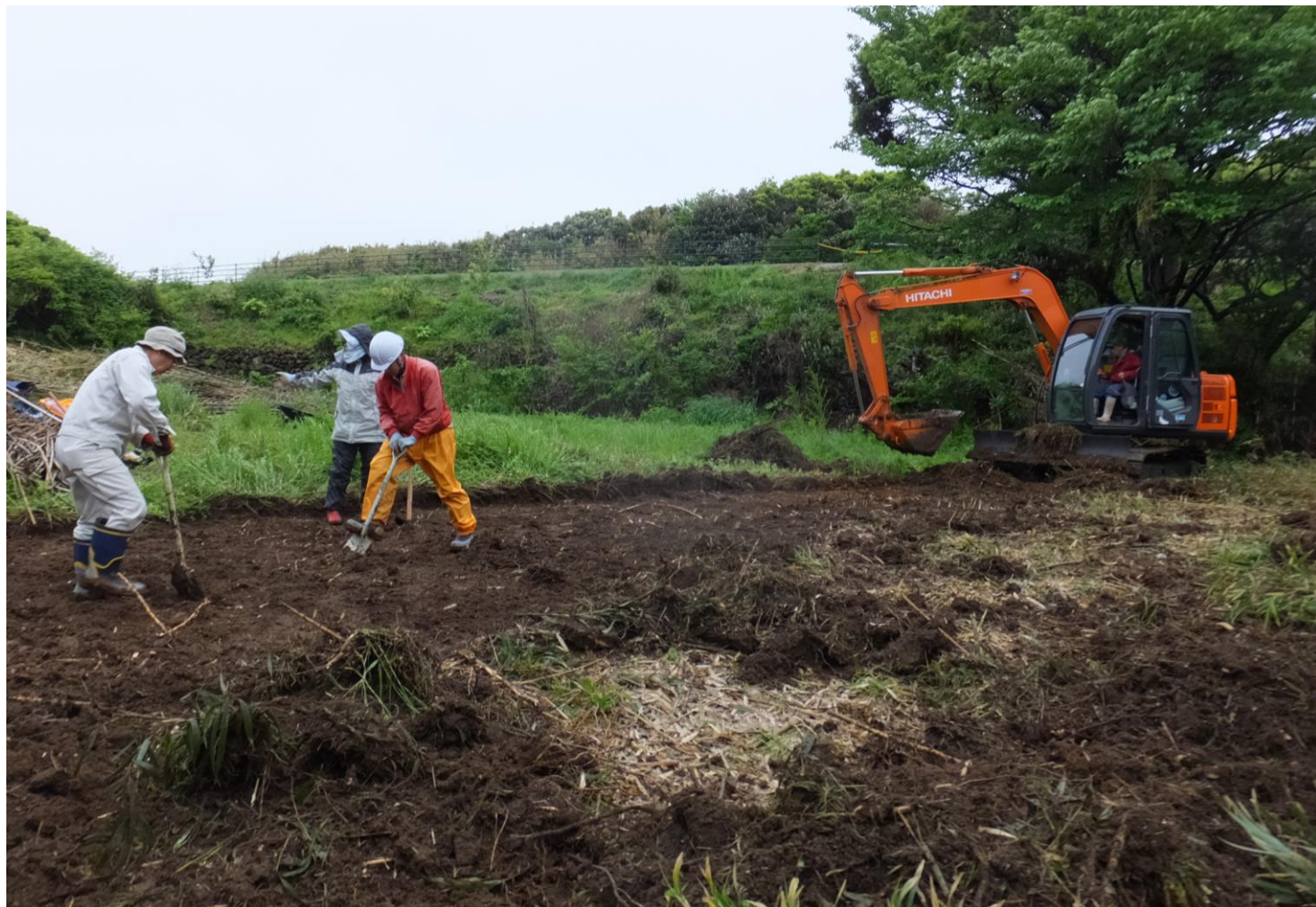
【写真】二日目 坑口設置前の敷地を整備する。竹林と雑草に覆われた敷地がトンネル建設現場へと変貌
