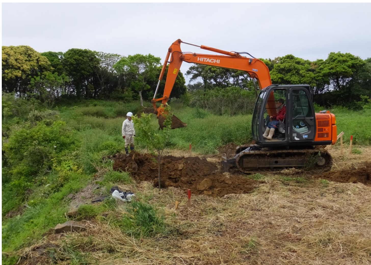
【写真】坑口となる箇所の土質を調べる。中央の赤い杭がトンネル中央部で正面奥の海岸へ進んでいく
