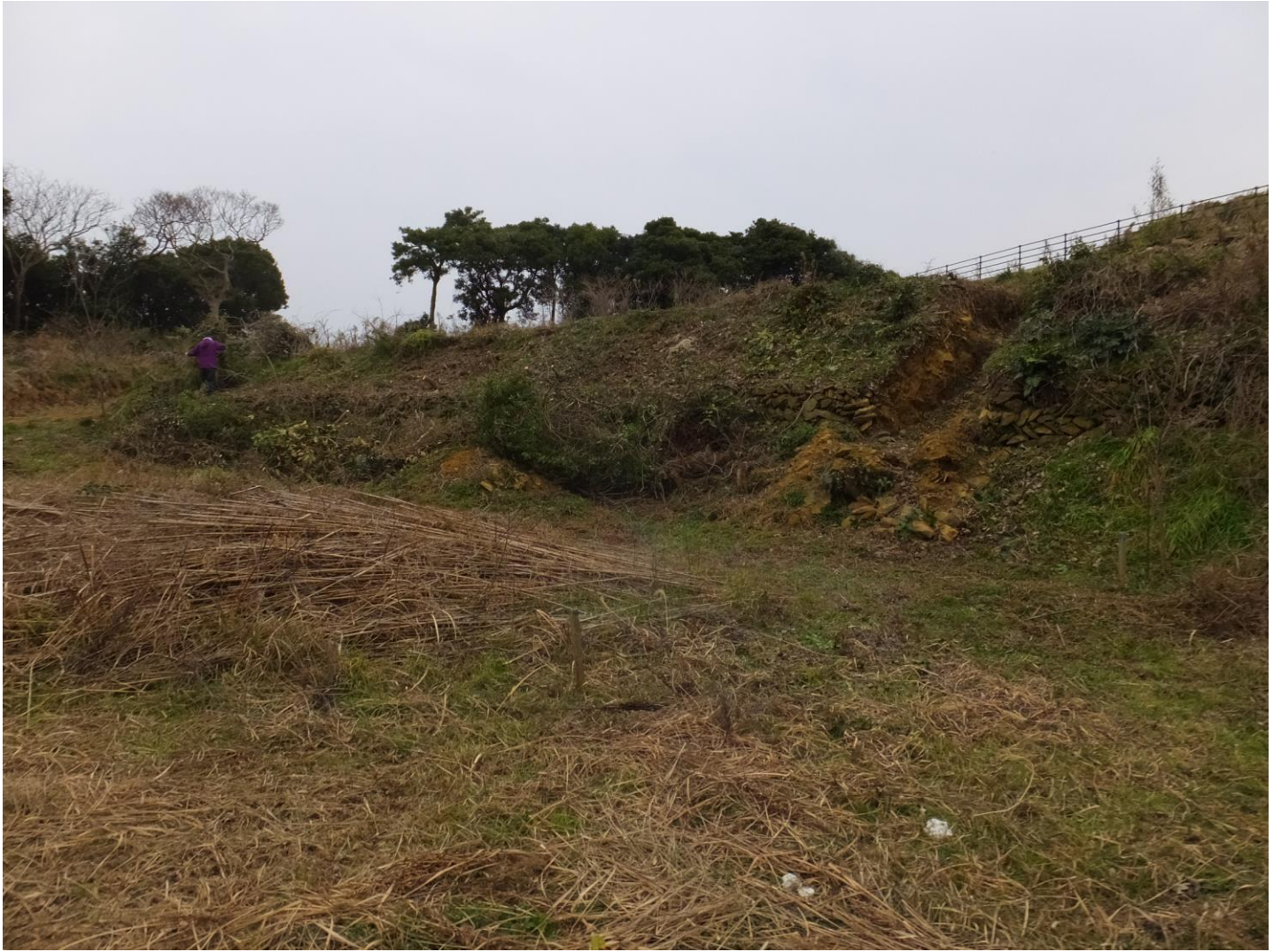
【写真】 香岐 芦辺斜坑口（ユンボで試掘した部分）予定地の周辺を草刈り、竹伐採をして整備
