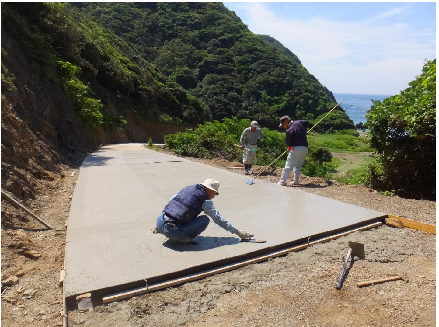
【写真】海岸口から上って100m地点までコンクリート舗装が進んだ 8月31日現在
