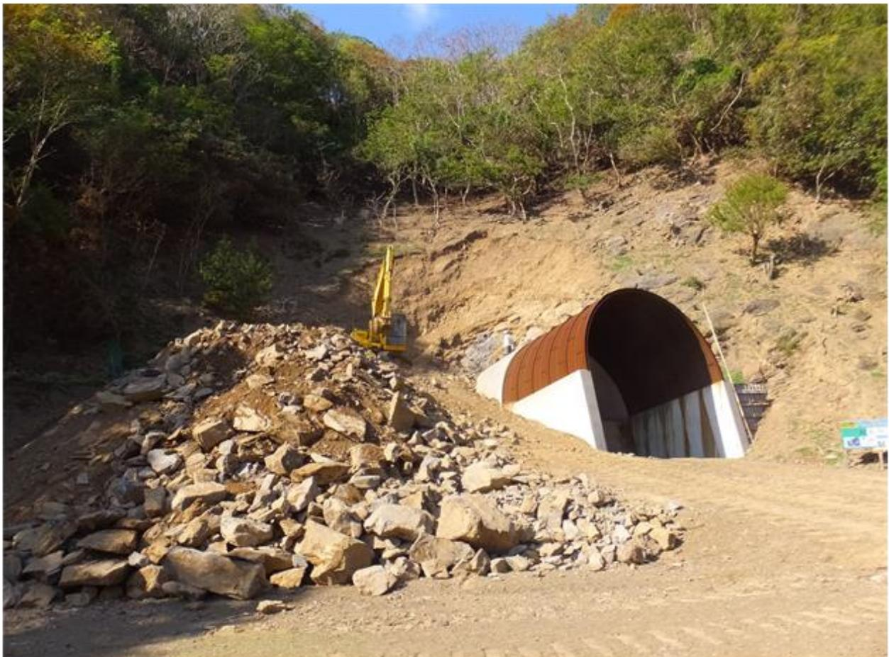
【写真①】 6m延伸する工事に着工 今、坑口前に掘り起こした土砂がうず高く積まれている
